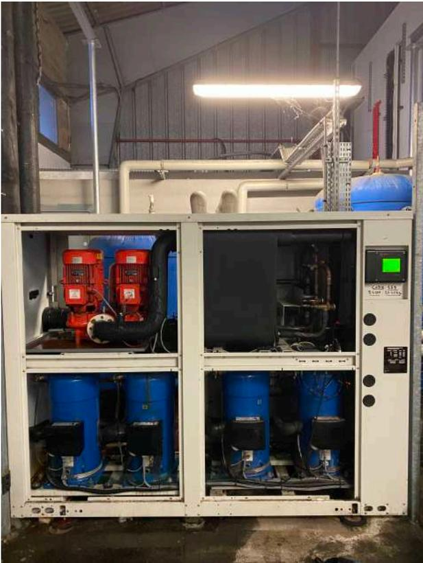
Equiper de quatre compresseur hermétique, et d'un échangeur à plaque contre courant. La centrale TRANE ci-contre assurera les échanges de chaleur nécessaire pour assurer le bon fonctionnement.
